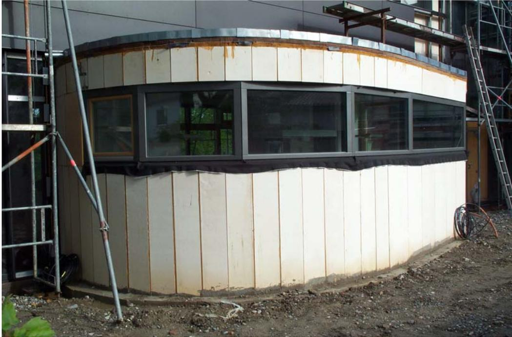
**Abbildung 5: Ansicht auf eine vakuumgedämmte, runde Außenwand. Die VIPs wurden nachträglich in Segmenten aufgeklebt.**
