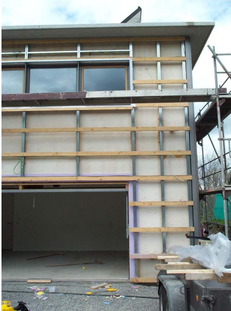
**Abbildung 4: Neu entwickelte Fassadenkonstruktion mit Hängeprofilen vom Dachüberstand. Druckkräfte werden über die Profile, Zugkräfte über die Bandanker direkt in die Außenwand abgeleitet.**
