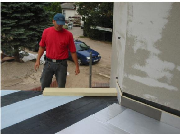
**unteres Bild:** Traufausbildung mit Polyurethan-Dämmbohlen und Wandanschluß mit senkrechter konstruktiver Dämmung aus PF-Hartschaum.
