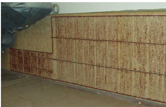
**oberes Bild:** Photographie der Wandinnenseite, nachdem die Vakuumdämmung aufgebracht ist.
