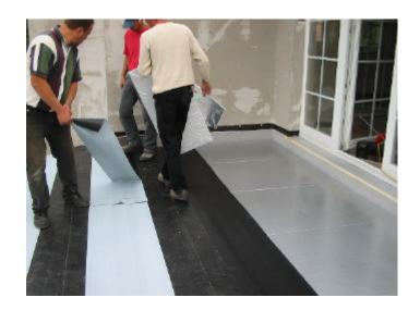
Nach der ersten Lage HassoVAC wurden die Bohlen im Attika- und Traufbereich gesetzt. Als Bohlen wurden Purenitbohlen verwendet, da hiermit auch in den Anschlussbereichen eine vernünftige Wärmedämmung erreicht wird. Außerdem lassen sich Purenitbohlen leicht bearbeiten. Geringe von der HassoVAC Dämmung nicht abgedeckte Stellen wurden mit hochverdichteten PU-Platten ausgefüllt und gedämmt.
