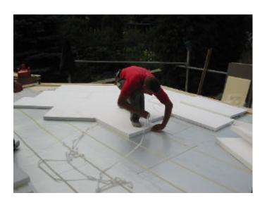
Nach der Verlegung des Gefälledaches konnte sofort mit dem Aufbringen der ersten Lage der Dachabdichtung begonnen werden. Hierfür wurde die vollflächig selbstklebende Dachbahn Hassopren in einer Breite von 1,08 m eingesetzt. Den Abschluss bildete die elasto-plastische Premiumbahn Kubidritt PLUS. Diese Oberlagsbahn gehört mit einer amtlich bestätigten Plastizitätsspanne von 180 K zu dem Besten, was derzeit auf dem deutschen Markt erhältlich ist.
