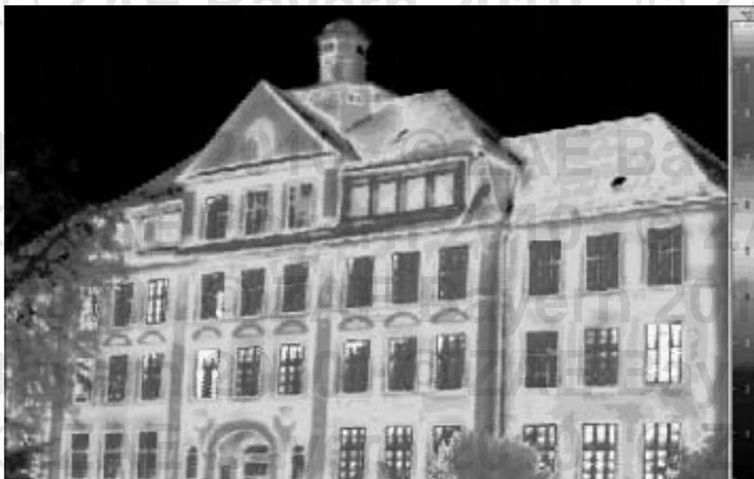
Im Vergleich zu opaken Fassaden im Passivhaus-Standard liegen die Wärmedurchgangskoeffizienten von hochdämmenden Verglasungen im Dreischeiben-Aufbau mit 0,5 bis 0,7 [ $\text{W m}^{-2}\text{K}^{-1}$ ] um einen Faktor 5, [12] - bei konventioneller Doppelverglasung bereits um einen Faktor von 7 - darüber. Durch die Verschärfung der Energieeinsparverordnung können konventionelle Fenster bereits in wenigen Jahren die gesetzlichen Anforderungen nicht mehr
